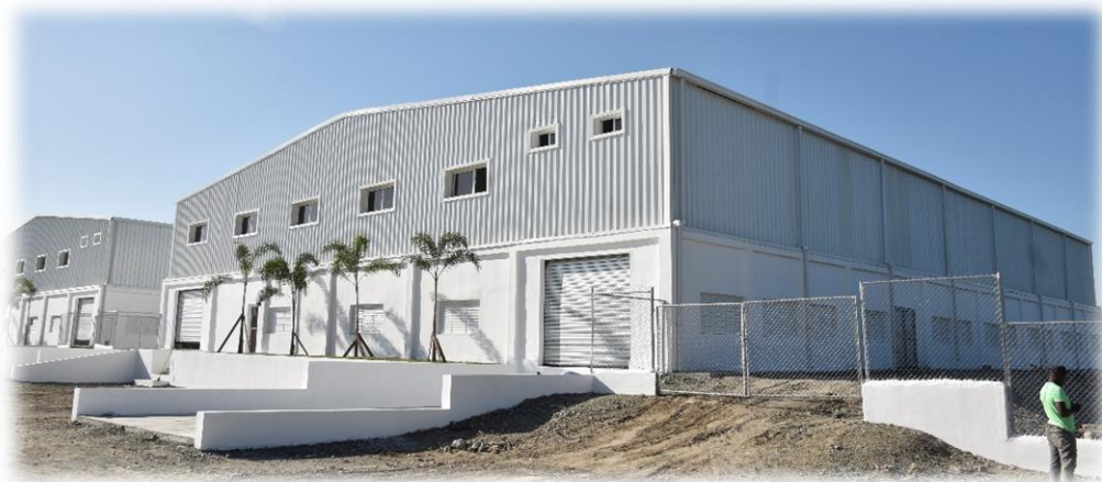
Fotografía: Nave recién construida en la nueva Zona Franca San Juan. Departamento de Comunicaciones.
